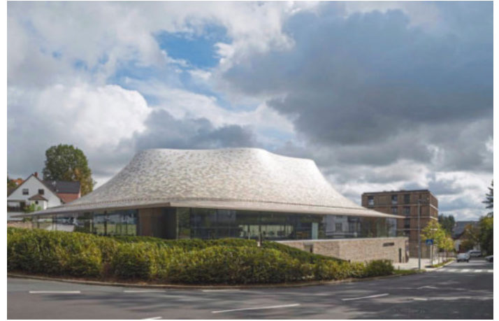
I Weit überspannt das mit kleinen Metallschindeln belegte, geschwungene Dach den Konzertsaal im Inneren des CasalsForums in Kronberg im Taunus.
