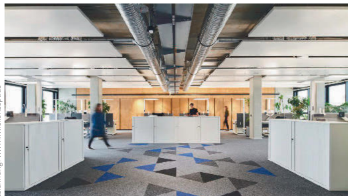
Die perforierte Front der gut 14 m langen, raumhohen Schrankfront im Open-Office-Bereich sorgt zusammen mit den Deckensegeln für eine gute Raumakustik.
